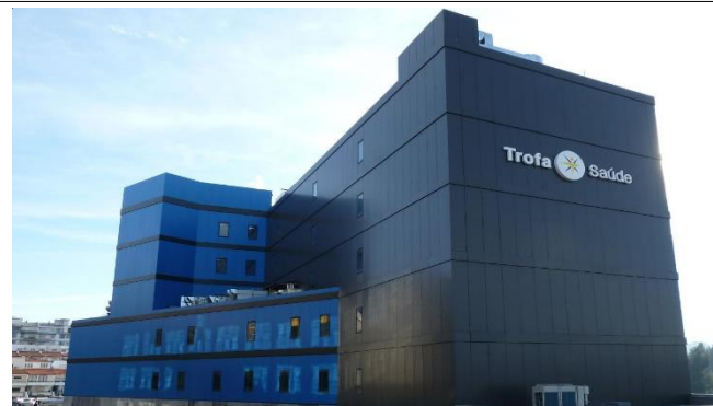
Grupo Trofa Saúde | Várias unidades Elevators and Escalators: 74
