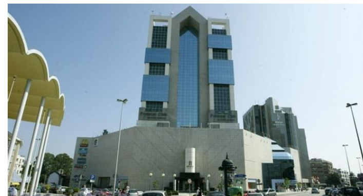
Shopping Cidade do Porto | Porto Elevators and escalators: 18
