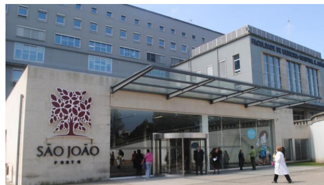
Centro Hospitalar e Universitário São João Elevators: 54
