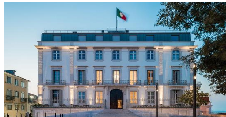
Palácio Verride Santa Catarina | Lisboa Elevators: 4
