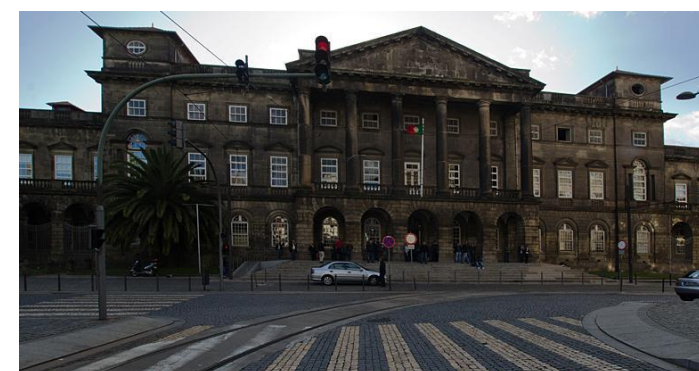
Centro Hospitalar e Universitário Santo António Elevators: 61
